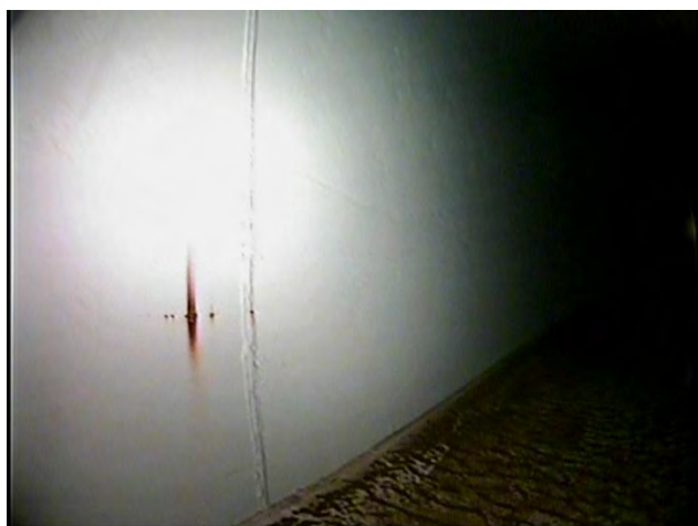
30. Wall Section 1 Rust Nodule
