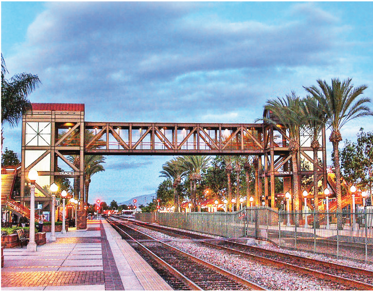
Bridge Over Tracks / Puente sobre las vías
